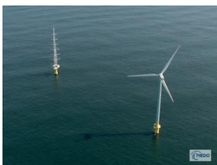
図 6-15 銚子沖の風力発電設備 (実証事業)
