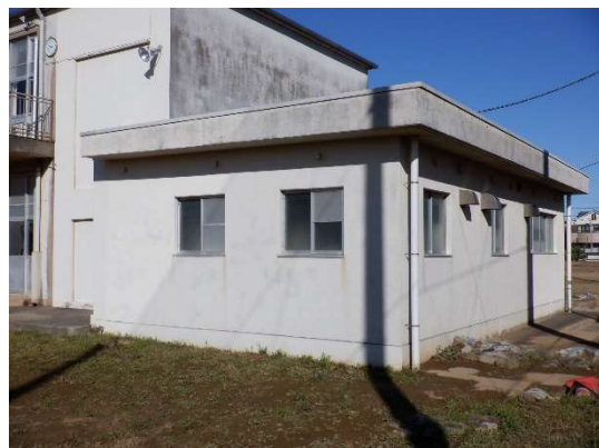
⑦トイレ棟
