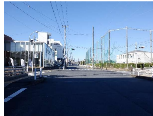
⑥南側市道1008号線交差点
