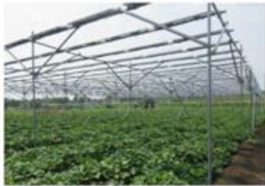
図 6-7 露地の畑の上部に設置されたパネル
