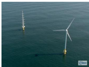
図 6-16 銚子沖の風力発電設備 (実証事業)
