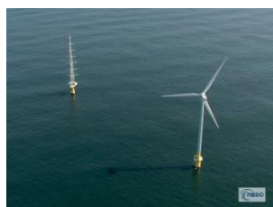
図 6-16 銚子沖の風力発電設備 (実証事業)
