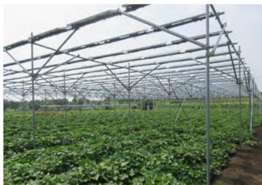
露地の畑の上部にパネルを設置
