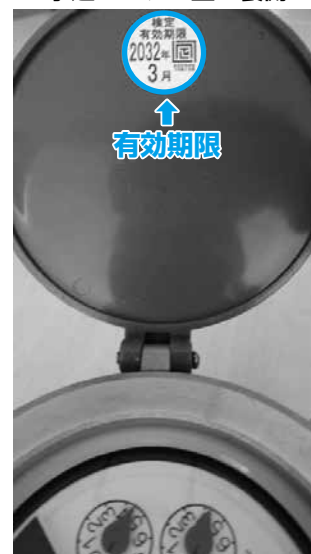
水道メーター蓋の裏側
