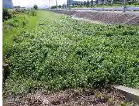
水路（コンクリートブロックライニング）での大量繁茂
