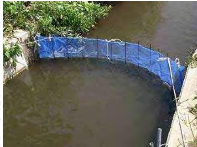
流出防止を目的とした網の設置例
