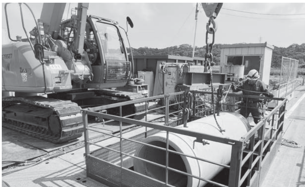
▲鞘管を地下7メートルに下ろしている様子
