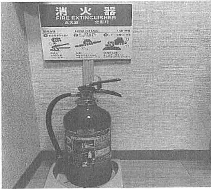
⑰ 相談室 消火器
