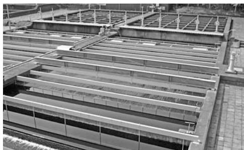
水源から送られてきた原水に凝集剤（ポリ塩化アルミニウム）を注入します。原水中に溶け込んでいる物質や浮遊物は、大きな粒子のかたまりとなり沈みます。次に、次亜塩素酸ナトリウムを注入して塩素消毒をします。
