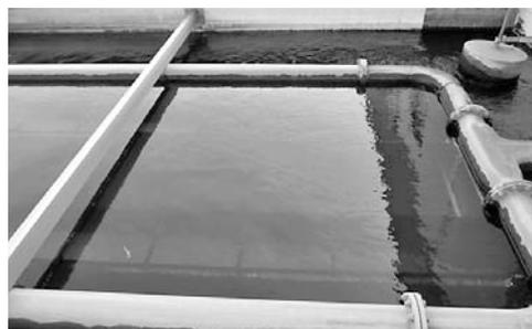
沈澱池で取り除けなかった原水中の細かい浮遊物を砂と砂利の層を通過させて取り除きます。水道水の出来上がりです。
