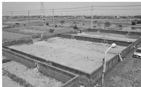
沈澱池、ろ過池で発生した汚泥を自然乾燥で脱水する設備です。場内に14床あります。
