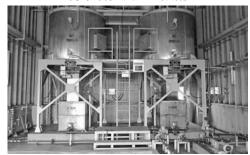
水質悪化時に粉末活性炭を取水ポンプの吸い込み口に送る設備で、粉末活性炭が導水管を流れていく間に異臭味成分、有機物等を吸着します。
