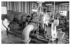
高度浄水処理された原水を取水ポンプで吸い上げ、道路に埋設された導水管を通して、約19km離れた本城浄水場に送っています。
