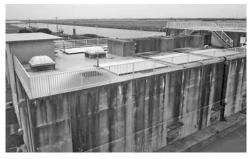
粒状活性炭(平均粒径 0.6mm) に微生物を繁殖させて、微生物の働きを利用した自然浄化と活性炭の吸着処理の両面から、異臭味成分、有機物を除去します。
