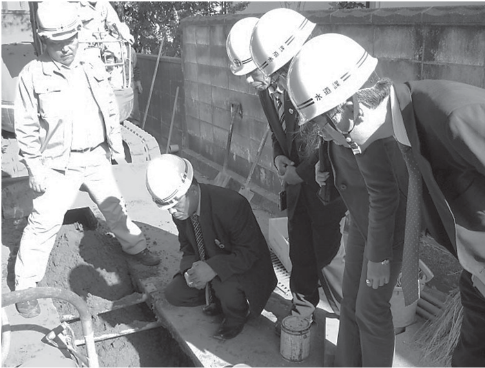
市水道課職員の説明を聞きながら、配管布設の様子を見ています。
