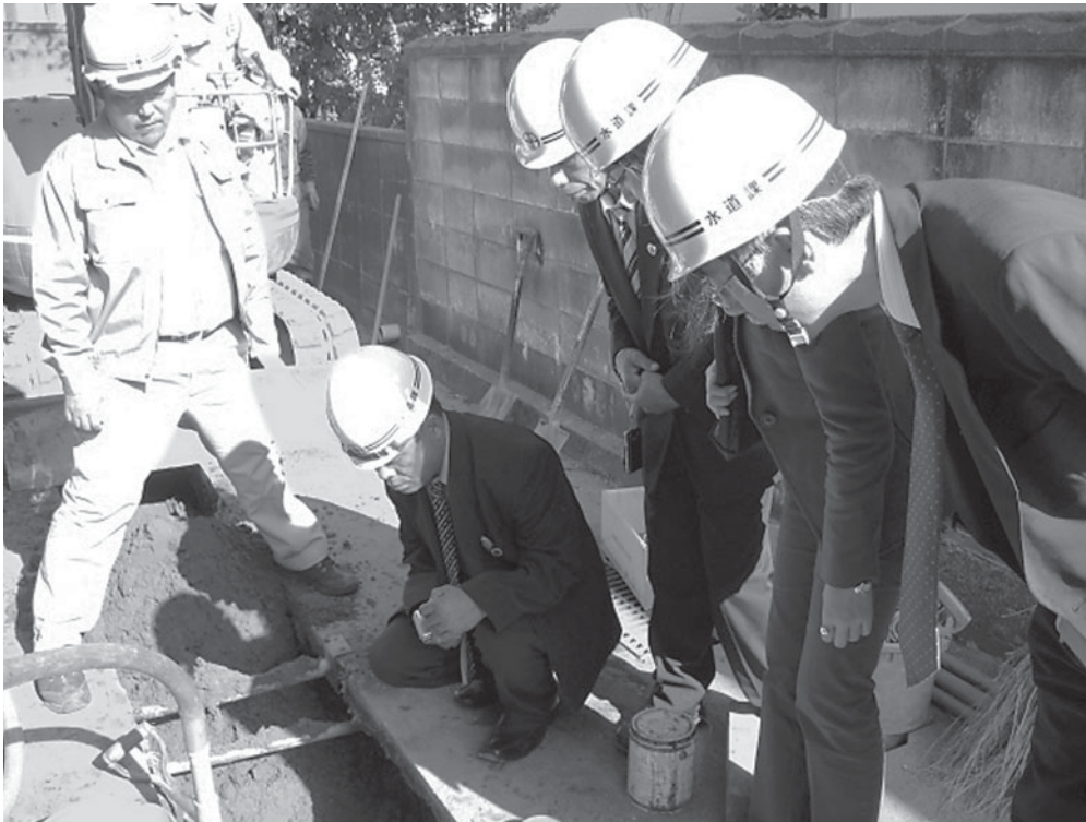
市水道課職員の説明を聞きながら、配管布設の様子を見ています。
