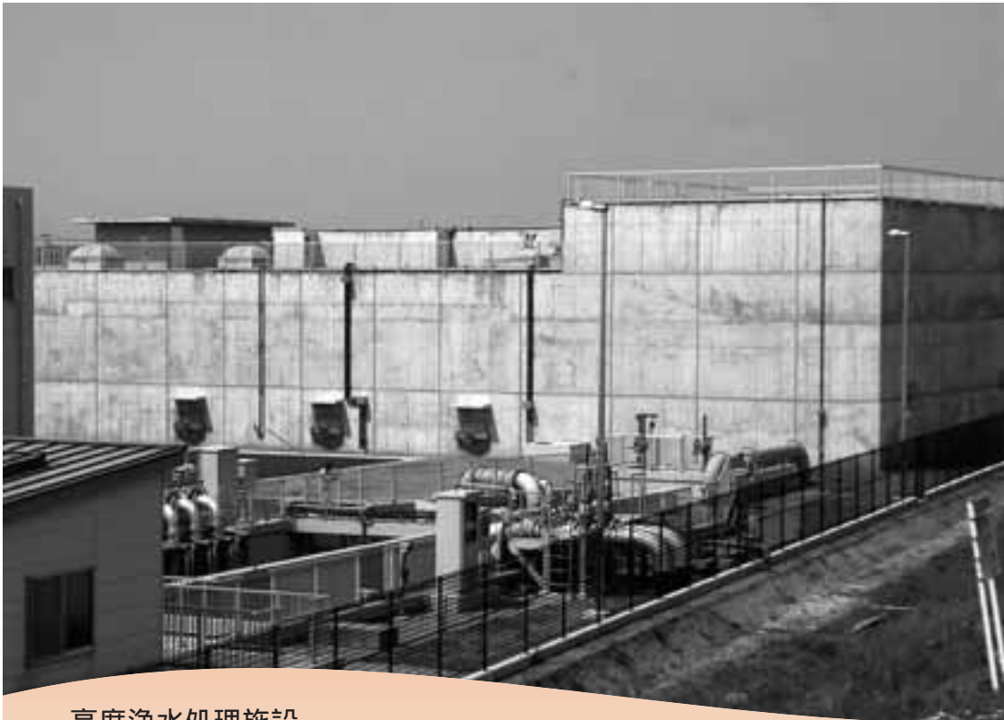
高度浄水処理施設
