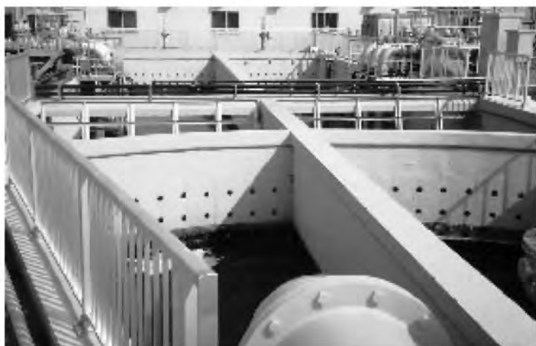
(左：処理水槽 右：原水槽)
