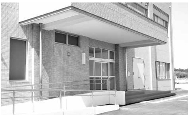
水道庁舎入口
