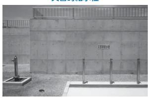
災害時に浄水池の水を配るための蛇口と消火栓を 設置しました。蛇口へは自家発電設備につないだ ポンプで水をくみ上げます。
