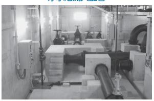
本城浄水場のろ過池と浄水池をつなぐ配管 2 系統と、東総広域水道企業団からの水を浄水池に入れる配管を設置しています。
