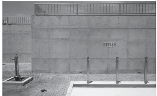
災害時に浄水池の水を配るための蛇口と消火栓を設置しました。蛇口へは自家発電設備につないだポンプで水をくみ上げます。
