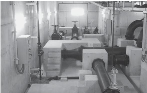
本城浄水場のろ過池と浄水池をつなぐ配管2系統と、東総広域水道企業団からの水を浄水池に入れる配管を設置しています。
