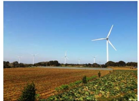
風力発電施設
