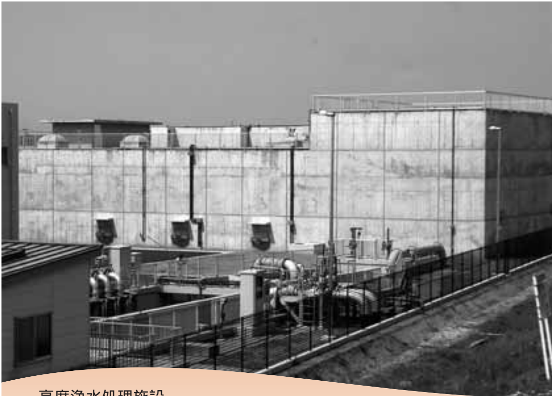
高度浄水処理施設
