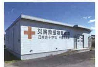
災害救援物資保管倉庫
