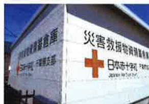
災害救援物資拠点倉庫(市川市)
