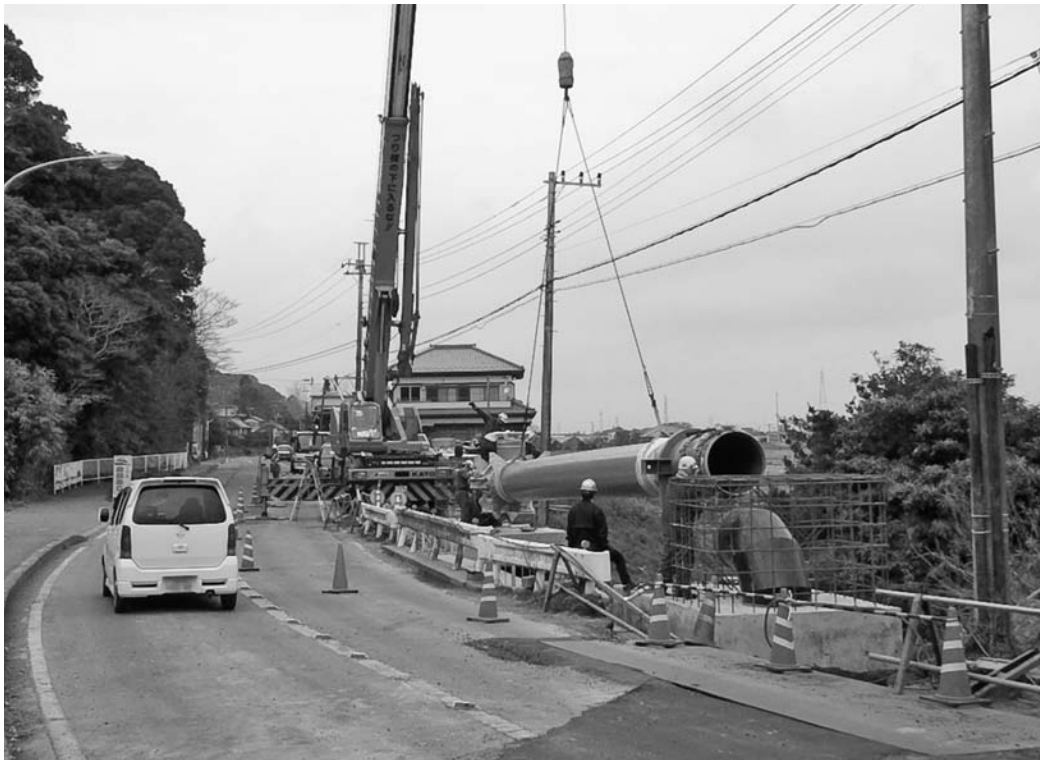
森戸川を横断する水管橋架設工事
