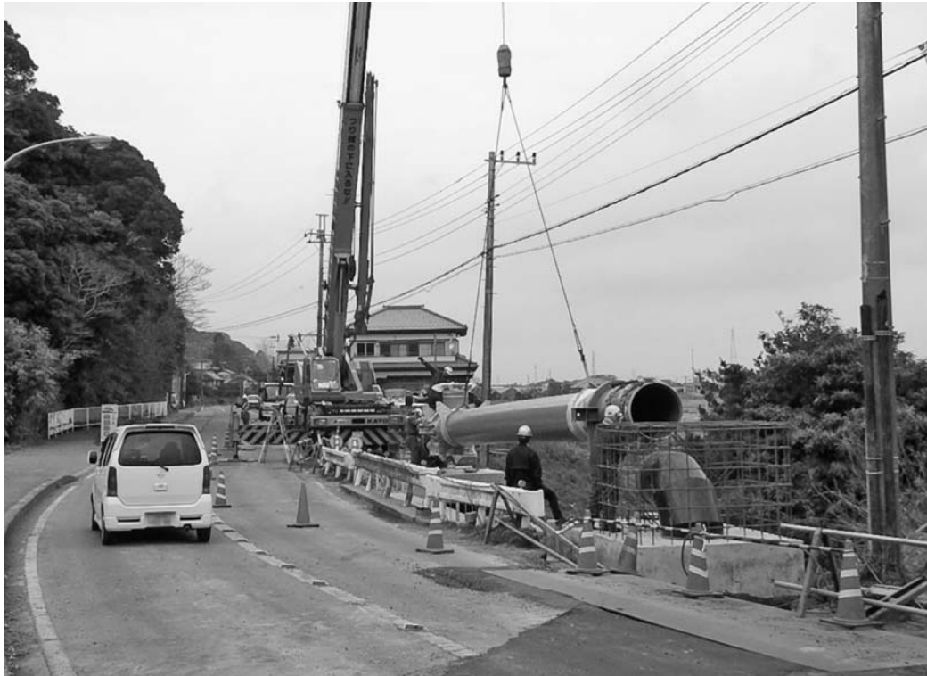
森戸川を横断する水管橋架設工事
