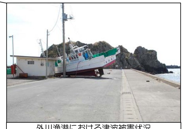
外川漁港における津波被害状況
