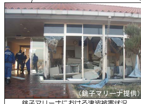
銚子マリーナにおける津波被害状況
