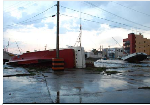
銚子港における津波被害状況
