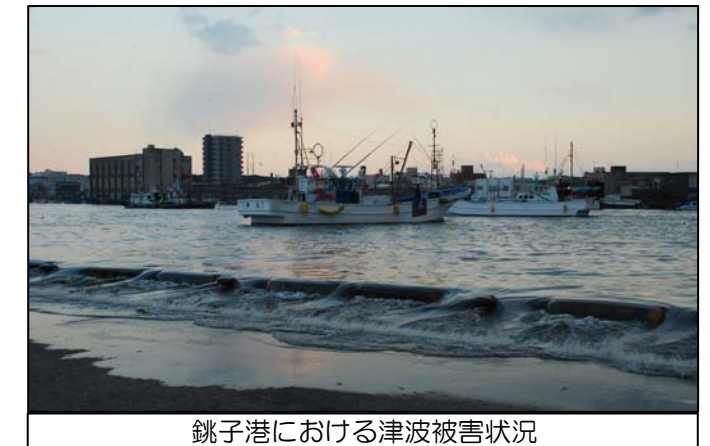
銚子港における津波被害状況
