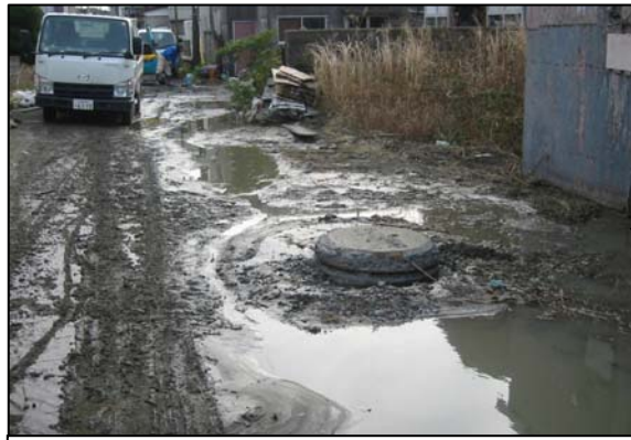
長塚町における液状化被害状況
