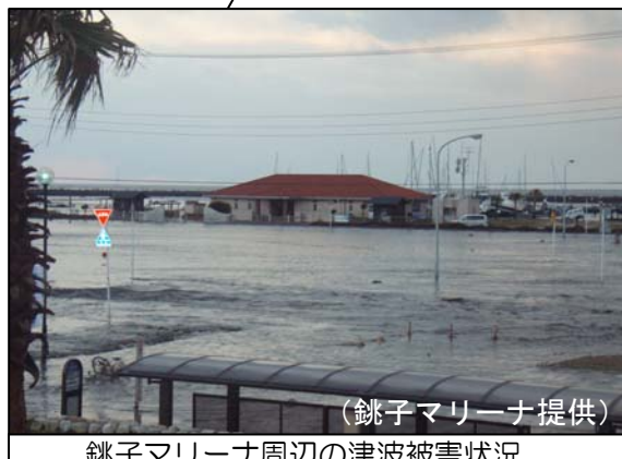
銚子マリーナ周辺の津波被害状況
