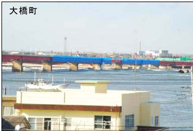
3月11日 15:33 利根川銚子大橋での津波遡上
