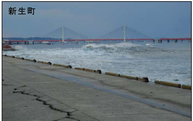
3月11日 17:04 利根川上流方向へ津波遡上
