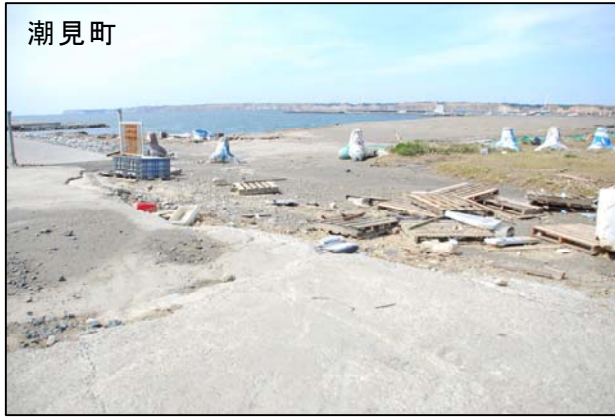
3月12日 津波により工場の資材流出
