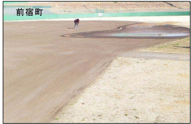
3月13日 野球場下の水道管が地震で破裂
