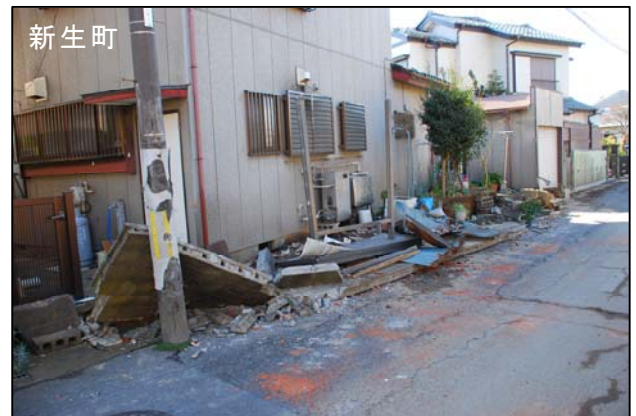
3月12日 地震によるブロック塀の倒壊
