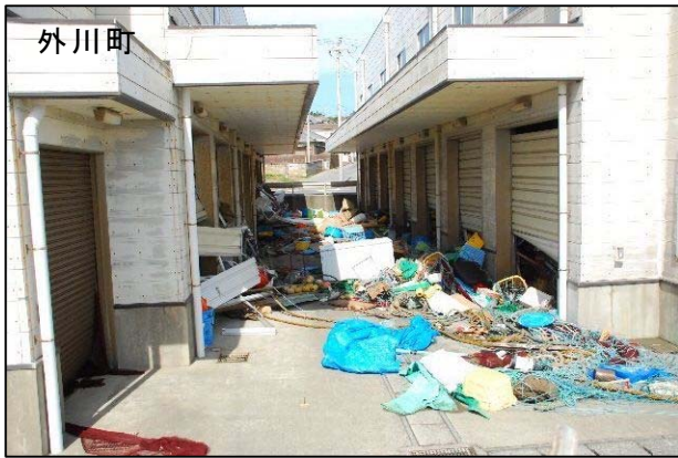
3月12日 津波浸水により倉庫内の漁具が散乱
