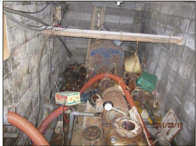
3月13日 津波浸水によりポンプ使用不能 (銚子市漁業協同組合提供)
