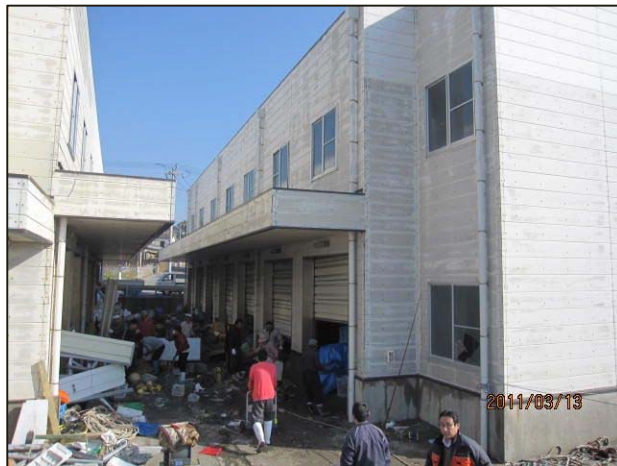
3月13日 外川支所犬若倉庫の被害状況 (銚子市漁業協同組合提供)
